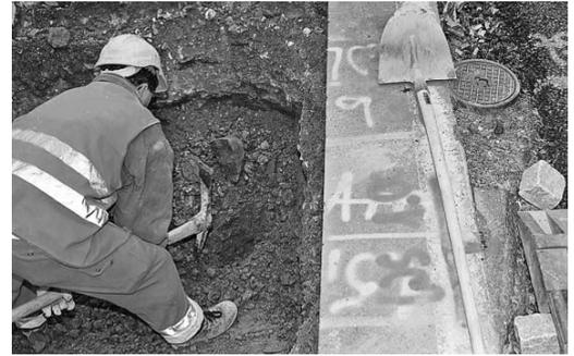
Fig. 1: effectuer des sondages dans le terrain. Voir «Neuf règles vitales pour le génie civil et les travaux publics», support pédagogique 88820.f (règle 1).
